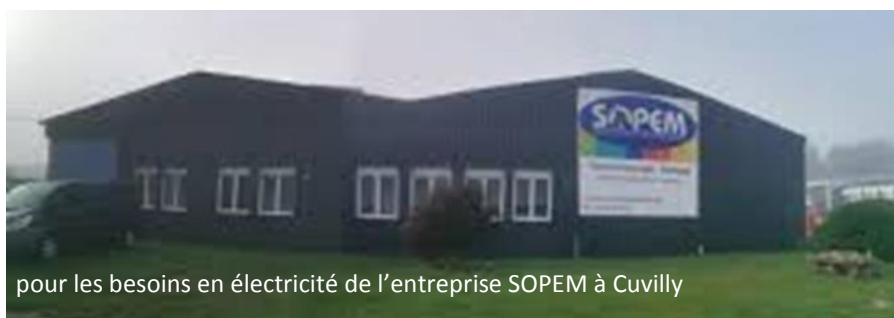
Installation de panneaux photovoltaïques
